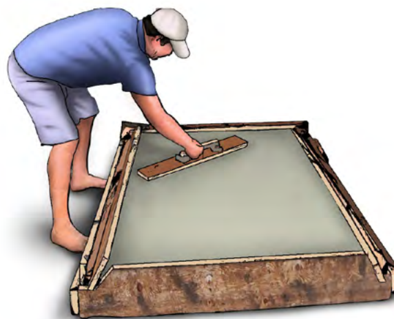
Figura 15. Acabado o aplanado de la estructura.
