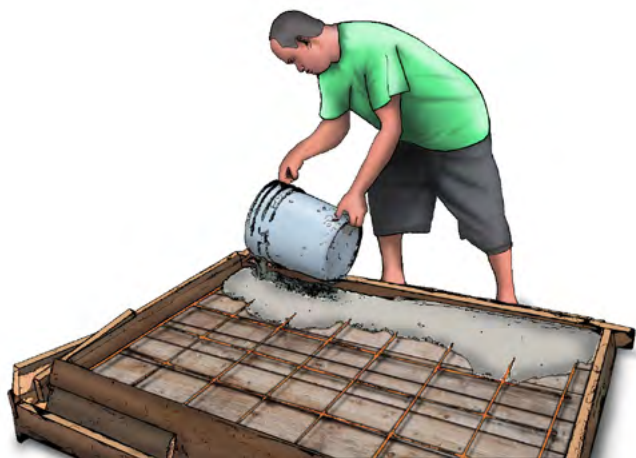
Figura 14. Vaciado de la mezcla sobre la estructura.
