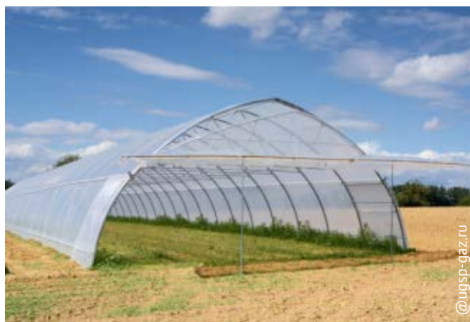
Рисунок 2 - Каркас теплицы с фронтальными стенками для вентиляции. Источник: [4]
