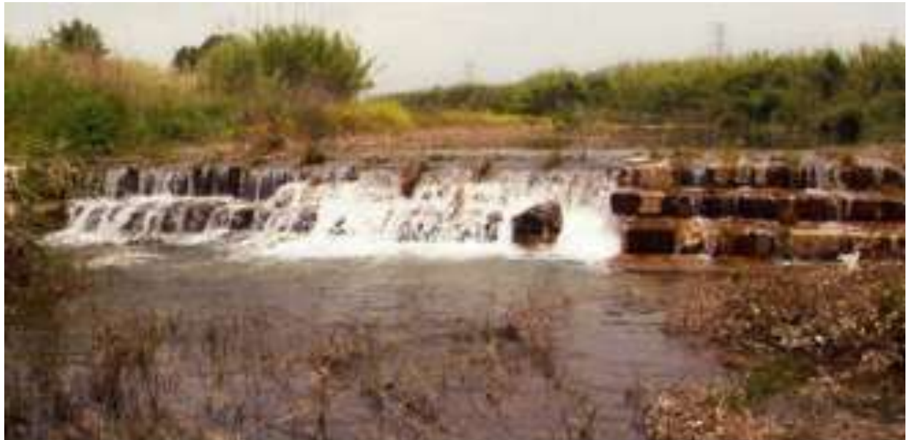
Figura 35. Assut (azud) y almenara de la acequia de Mestalla Fuente: (GUINOT & SELMA, 2005)
