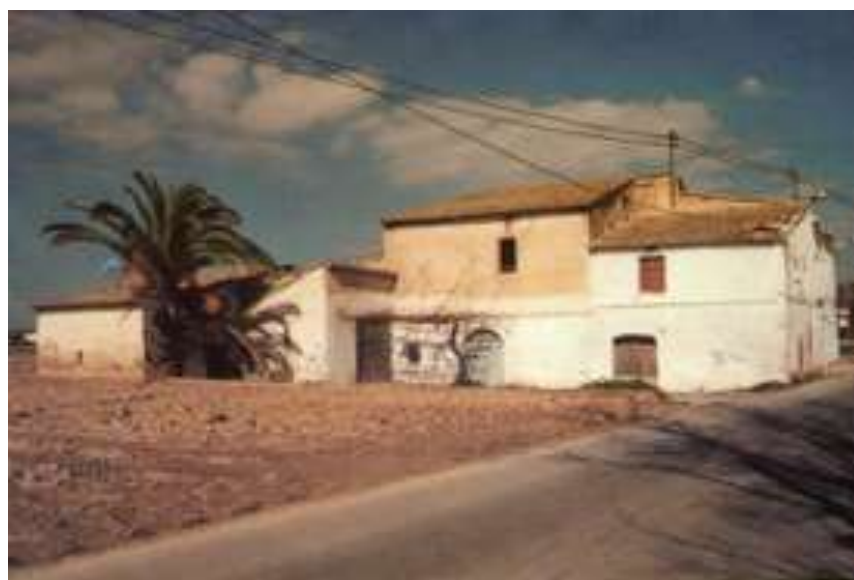
Figura 65. Alquería del Roig del Cristo. Pouet de Campanar Fotografía de Antonio Falcó
