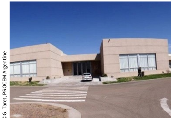
Figure 15: Installation d'élevage en masse et de stérilisation des mouches à Mendoza, Argentine
