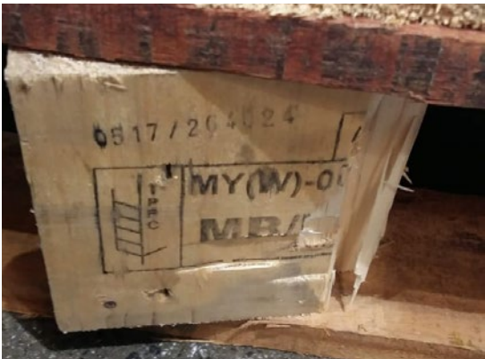
La marque est endommagée et non lisible.
