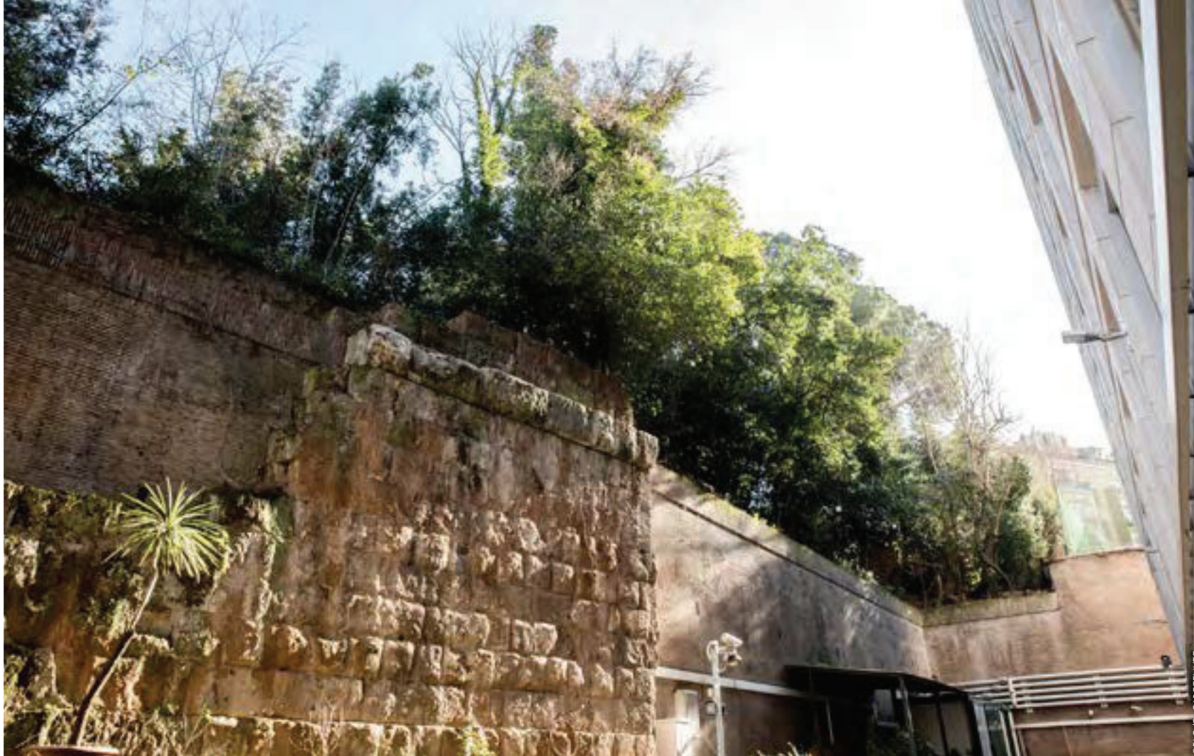
Muro de terrazas romano en Opus quadratum , de toba y travertino, del siglo II a.C., visible tras el edificio C del complejo de la FAO.
